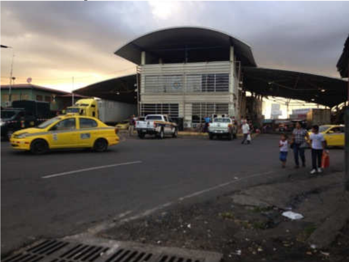
Fotografía 1. Vista frontal del Paso Fronterizo Paso Canoas
