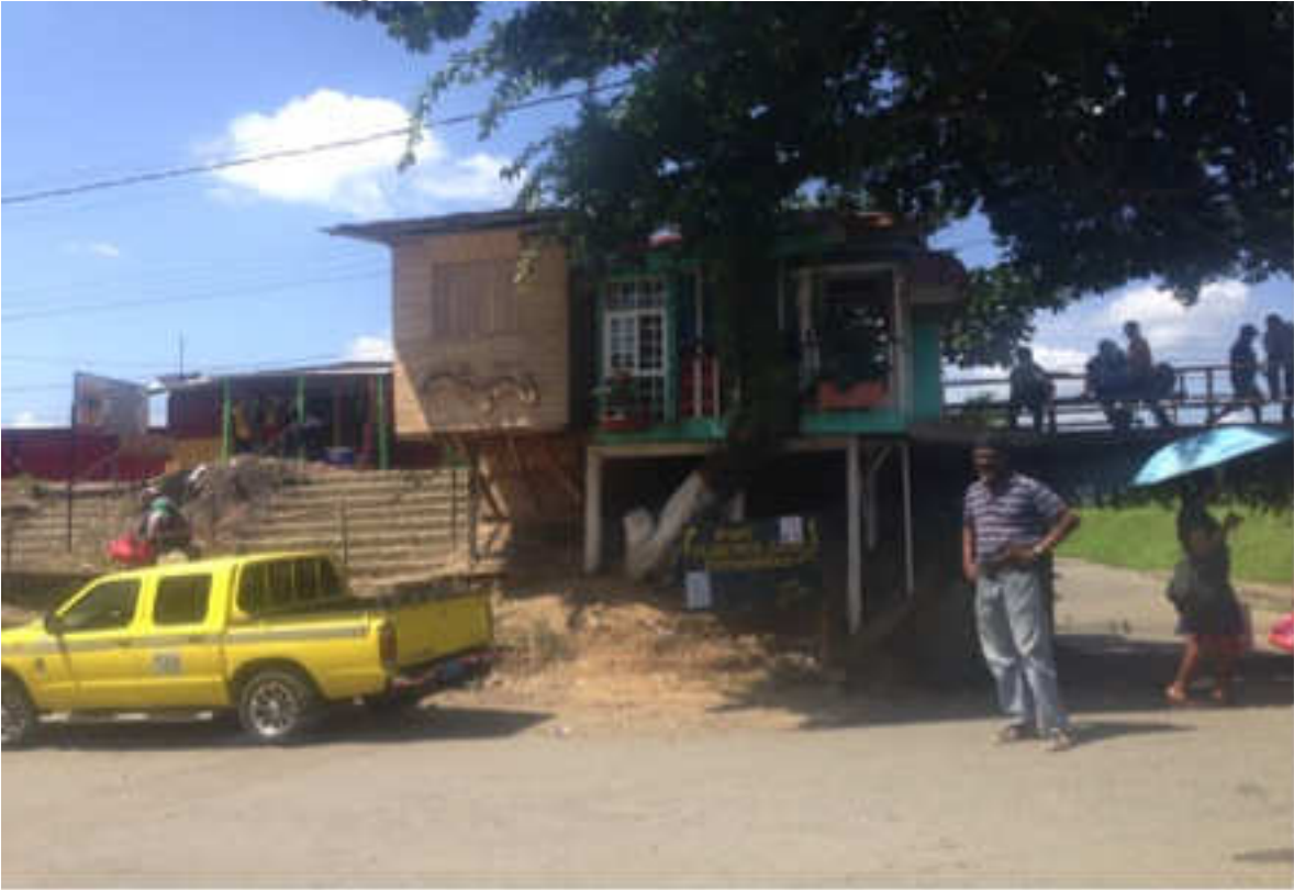
Fotografía 7. Locales ubicados en derecho de vía
