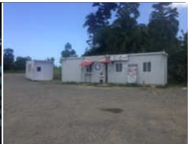
Fotografía 6. Instalaciones Autoridad Nacional de Aduanas
