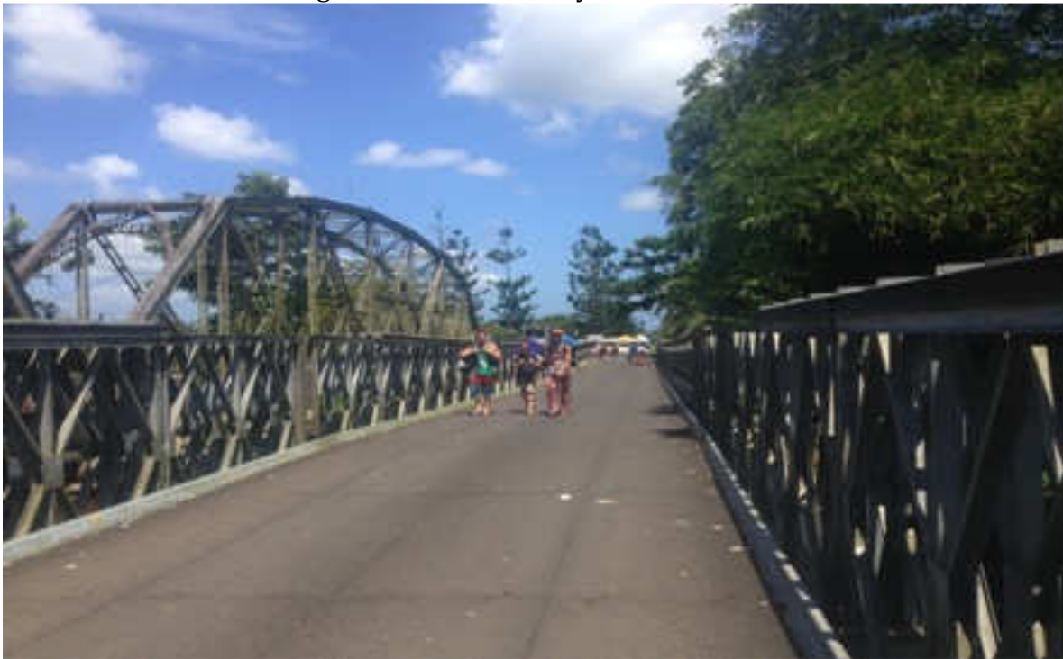
Fotografía 4. Puente Bailey sobre río Sixaola.
