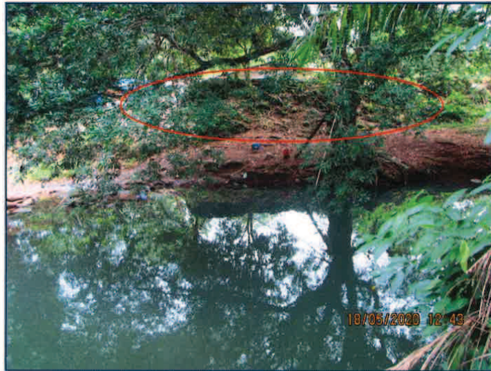
Foto 8. Vista del dique de roca localizado en la orilla derecha de la Quebrada Grande. Fuente: JACUM, mayo de 2020.
